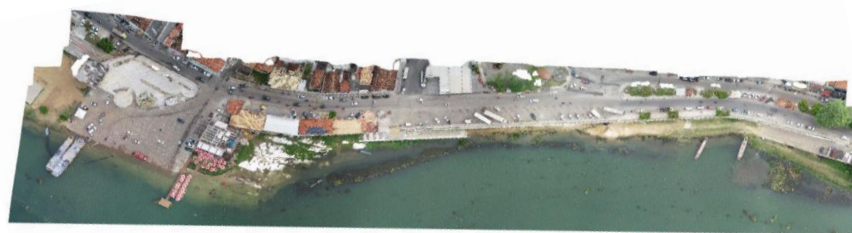
Áreas com pontos de esgotos em Propriá
