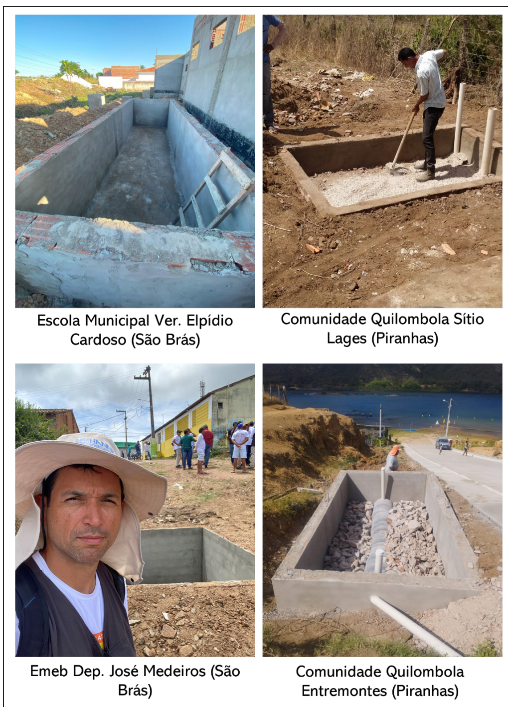
Figura 5: Implantação das fossas agroecológicas nas novas instituições contempladas pelo projeto.
