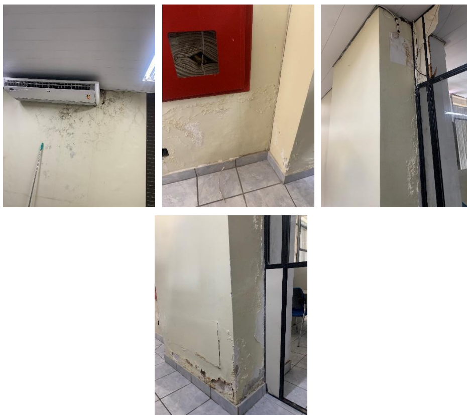
Estrutura física do prédio da Biblioteca Central contendo infiltrações e fios expostos.
