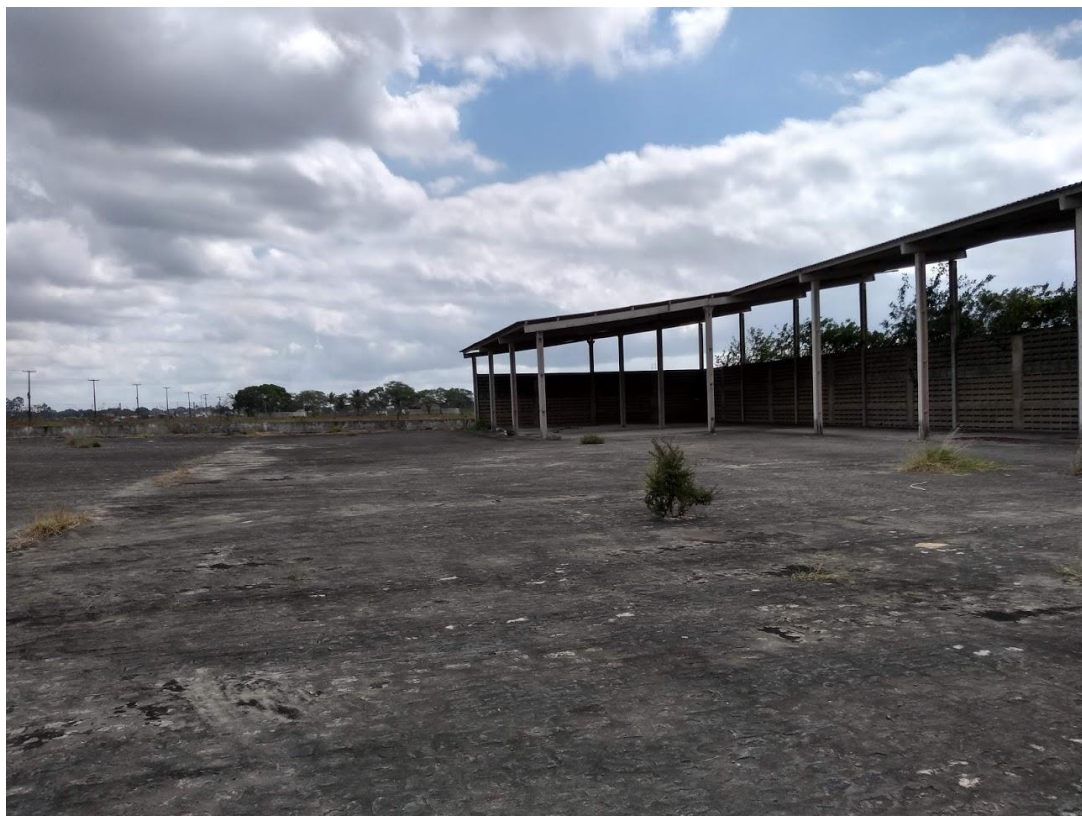
Foto 4: A garagem permanece sem utilização, aguardando a finalização de ajustes.
