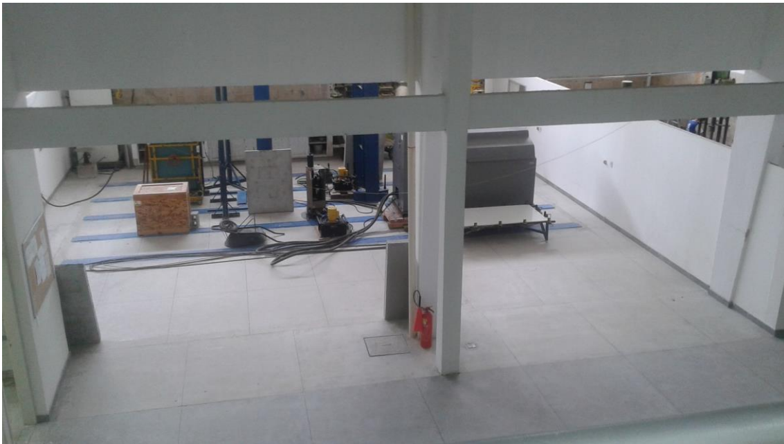
Foto 4: Prédio do Lema/CTEC: local da visita da equipe de auditoria para observar as condições físicas da obra concluída.
