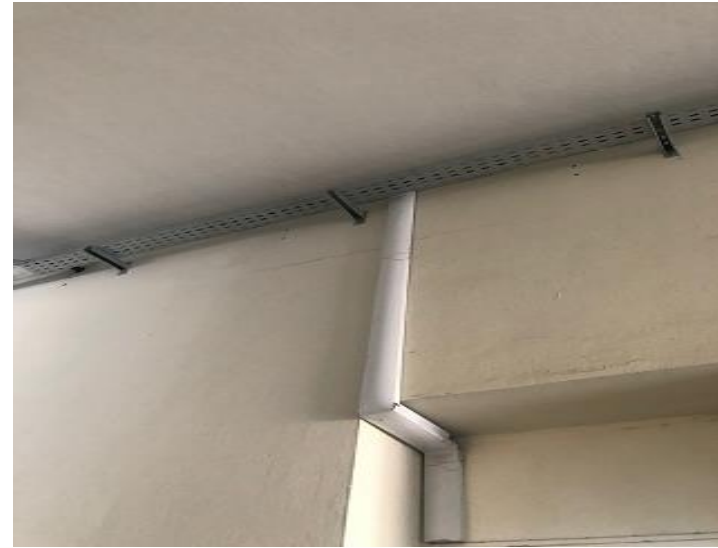
Foto 04: Instalações da nova rede elétrica.
