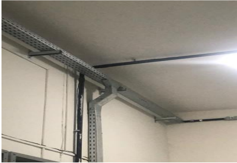
Foto 03: Instalações da nova rede elétrica.
