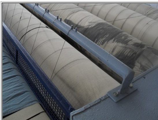
Material que recobre a calandra rasgado
